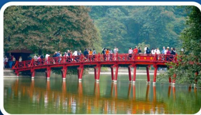
สะพานแสงอาทิตย์
