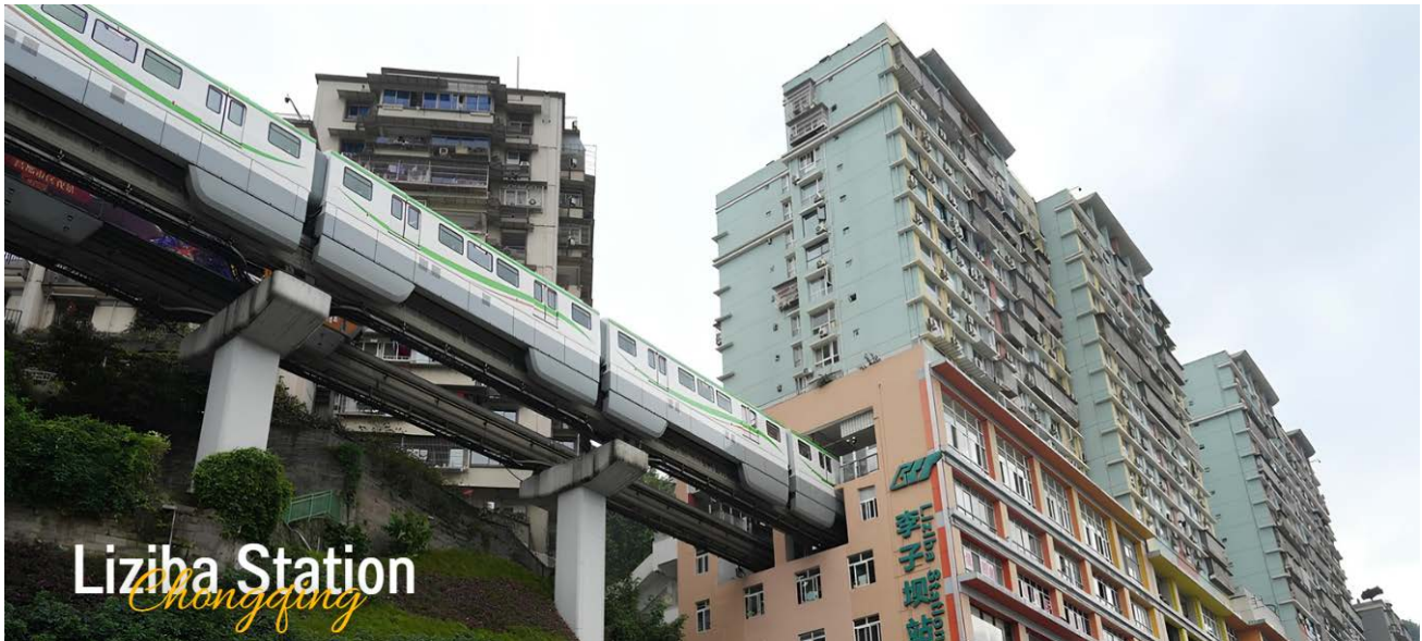
รถไฟฟ้าทะลุตึก (Liziba Station)
